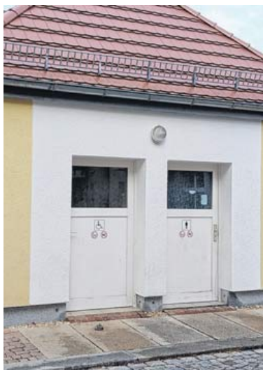
Erneut von Vandalismus betroffen: das WC am Kirchplatz in Werdau.
